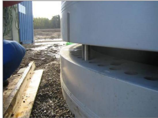
Figure 57 – Assemblage de la première section de la tour (source : VESTAS)
