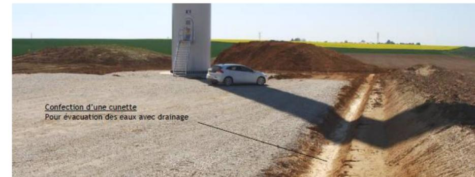
Figure 51 : Exemple de cunette réalisée en bordure de voirie (source : Vestas)
