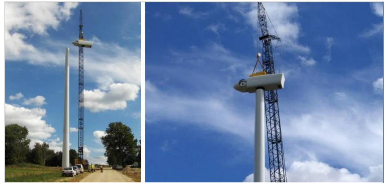
Figure 60 – Fixation de la nacelle sur la tour (source : VESTAS)
