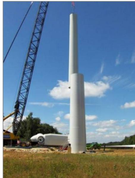
Figure 58 – Assemblage de la deuxième section de la tour (source : VESTAS)
