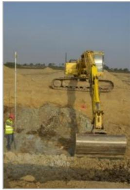
Figure 54 – Fouille de la fondation (source : VESTAS)
