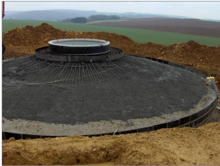
Figure 44 : Exemple de ferrailage en radier pour une éolienne (chantier en cours)
